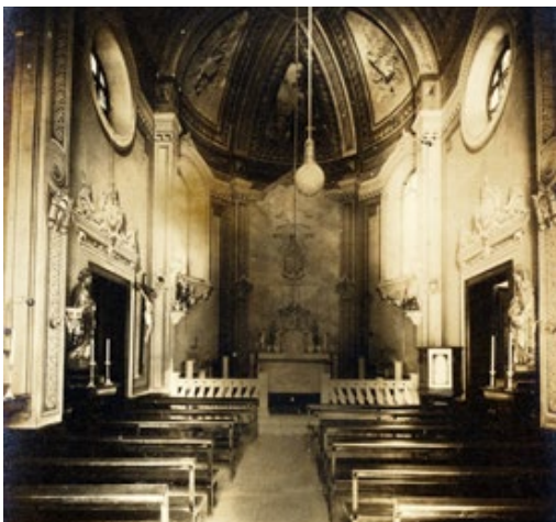
Figura 6: Interior de la capilla del Hospital San Roque (1910)
