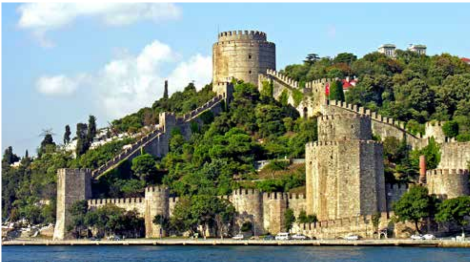
Foto 11: Fortaleza Rumeli Hisan, construida por Mehmet en 1451.
