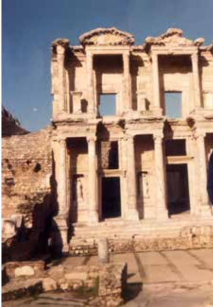
Foto 19: Fachada de la biblioteca de Éfeso.
