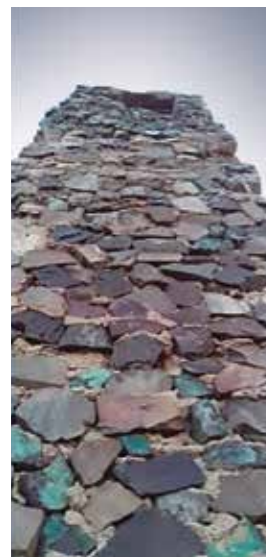
Figura 18: Presencia de cobre en el material de construcción.
