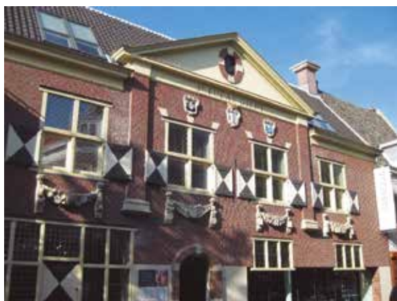
Figura 3: Edificio de la Cofradía de San Lucas en Delft, que se conserva tal cual era en la época de Vermeer.
