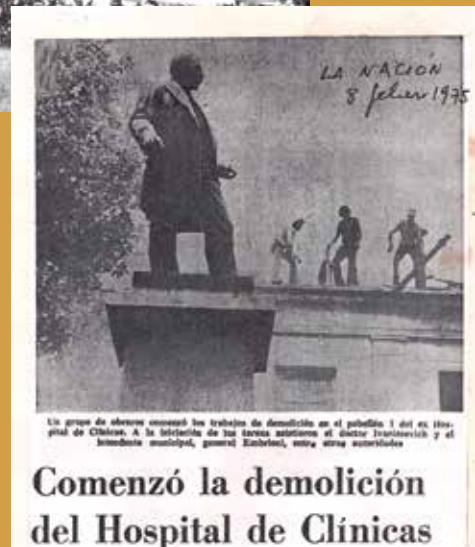
Figura 4: Nota del diario La Nación sobre el comienzo de la demolición del viejo Hospital de Clínicas.
